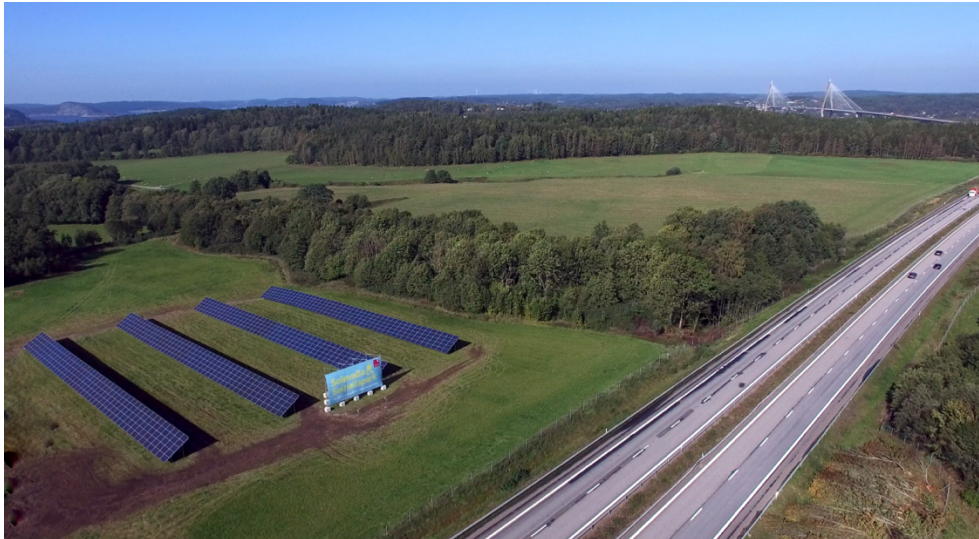
Figur 3. Referensparken i närheten av Uddevalla, där det är tydligt att en reklamskylt skuggar den tredje raden med solcellsmoduler.
