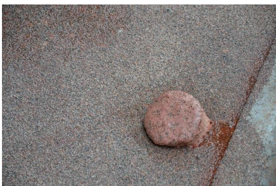
Figur 2.18 MMA-primer ska inte hällas i fuktigt hål (Foto: Y Edwards)
