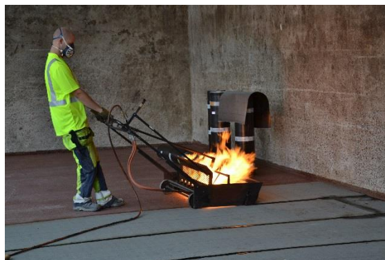
Figur 2.21 Mattan svetsappliceras med överlapp och skarvförskjutning (Foto: Y Edwards)
