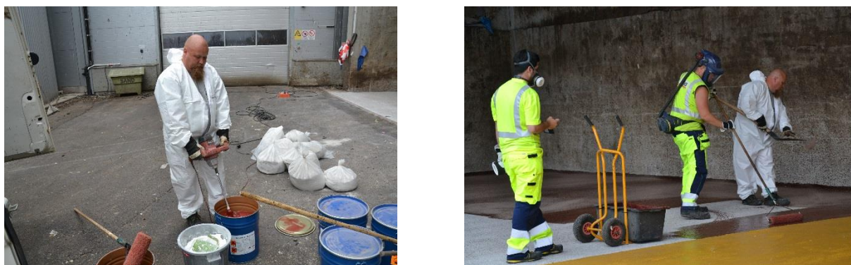
Figur 2.16 MMA-primern blandas och läggs ut (Foto: Y Edwards)
