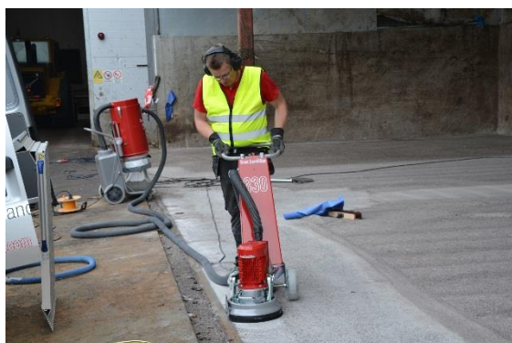
Figur 2.6 För kantavfasning krävdes mindre maskiner som komplement (Foto: Y Edwards)
