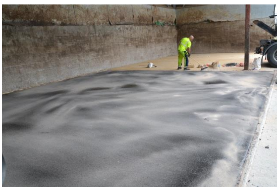
Figur 2.27 Den färdiga gjutasfaltbeläggningsen har avsändats (t v) och fogarna fylls med Nabogum fogmassa (Foto: Y Edwards)
