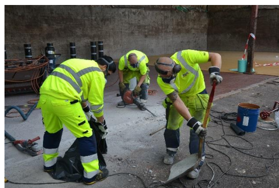
Figur 2.20 Mer betong bilas bort längs ytterkant (Foto: Y Edwards)
