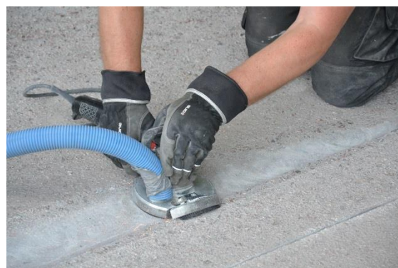
Figur 2.6 För kantavfasning krävdes mindre maskiner som komplement (Foto: Y Edwards)
