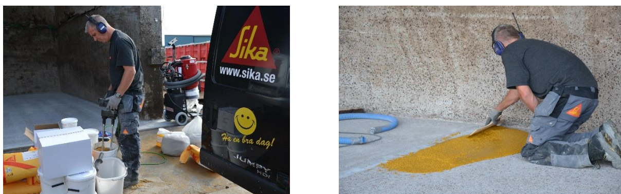
Figur 2.10 Blandning och försök med att lägga ut en slamma före den egentliga slitbeläggningen (Foto: Y Edwards)
