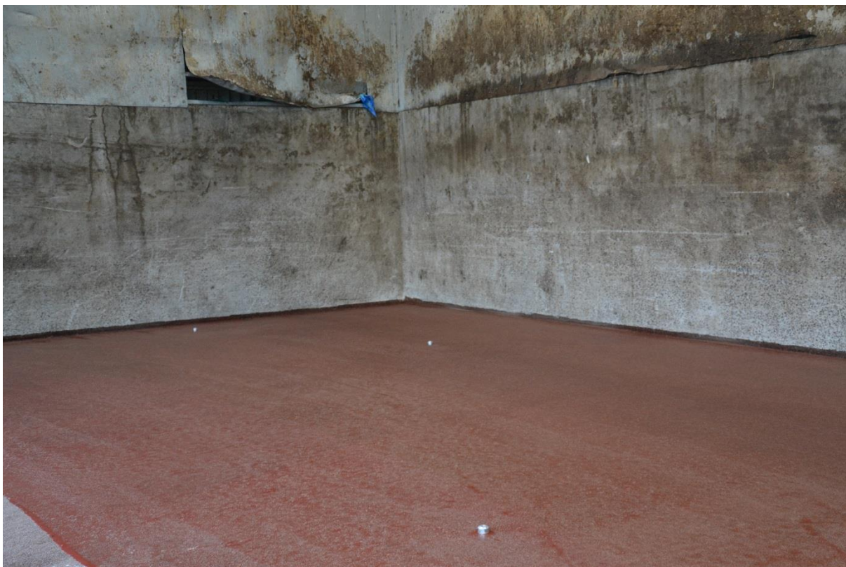
Figur 2.17 MMA-primerbehandling redo för provdragnig (Foto: Y Edwards)
