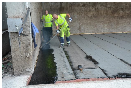
Figur 2.25 Gjutasfalt töms upp i kärra och utläggningsarbetet börjar (Foto: Y Edwards)
