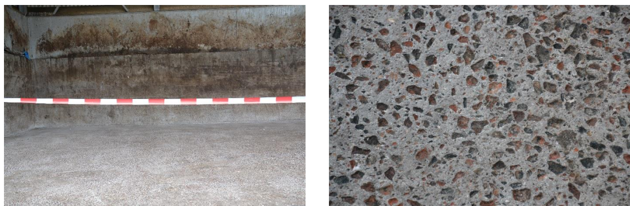
Figur 2.3 Betongytans utseende efter rengöring (Foto: Y Edwards)
