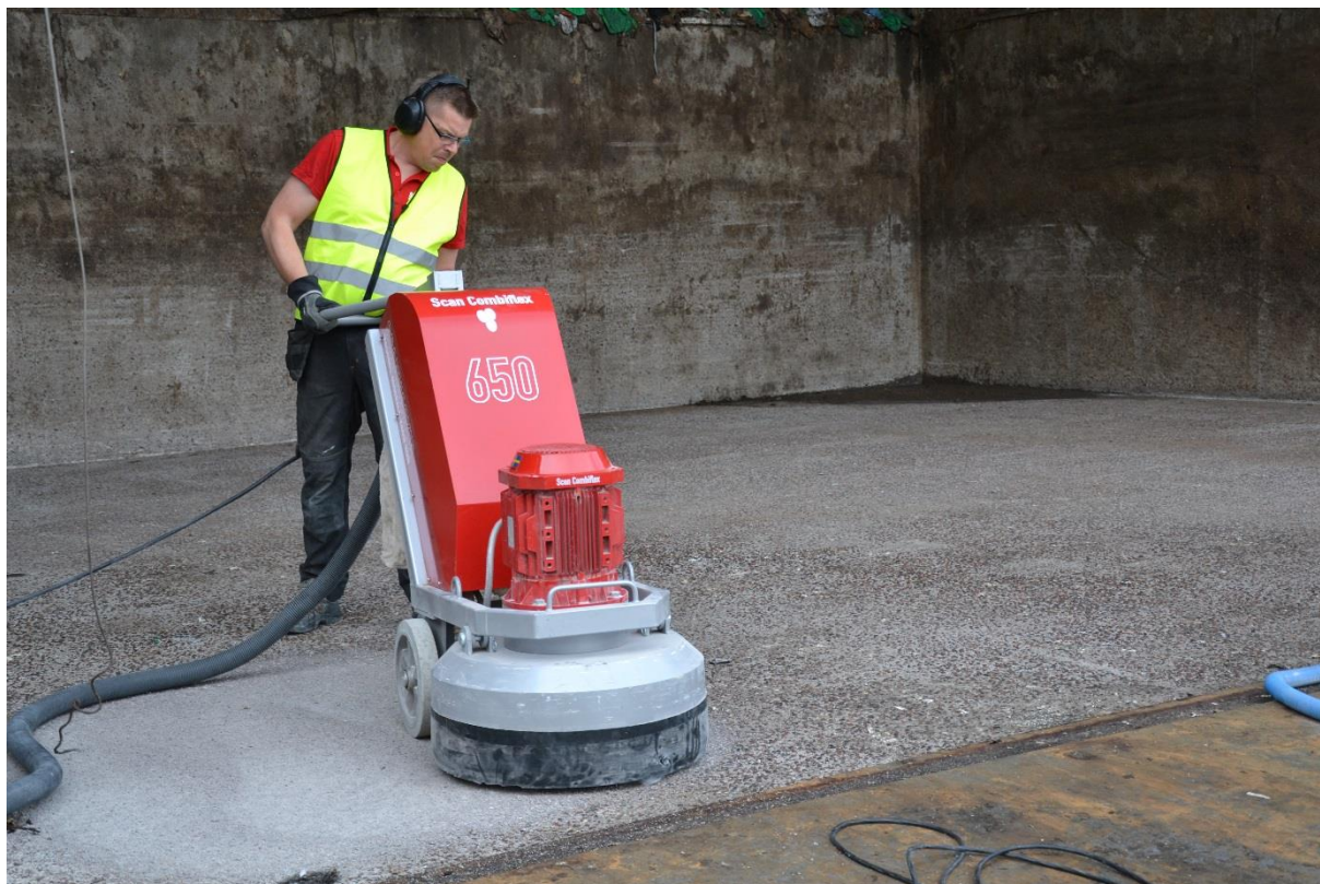
Figur 2.5 Erik på Scanmaskin drar igång arbetet på betongplattan med stora slipmaskinen (Foto: Y Edwards)
