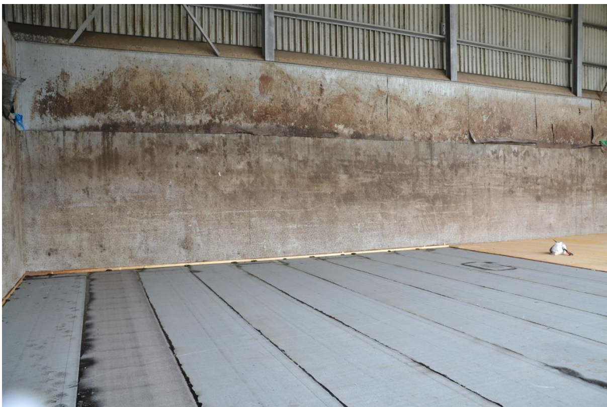
Figur 2.23 Alla mattvåder på plats (Foto: Y Edwards)
