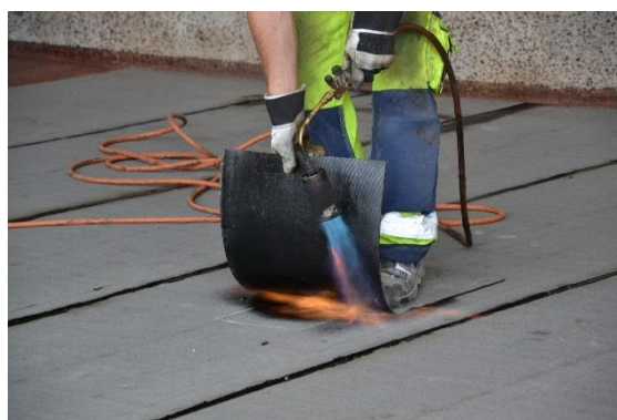
Figur 2.22 Rivprov görs och provstället lagas därefter (Foto: Y Edwards)
